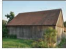
Satteldach eines Stadels
