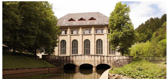
Abbildung: Kraftwerk Arnstein (Foto: Eck)
