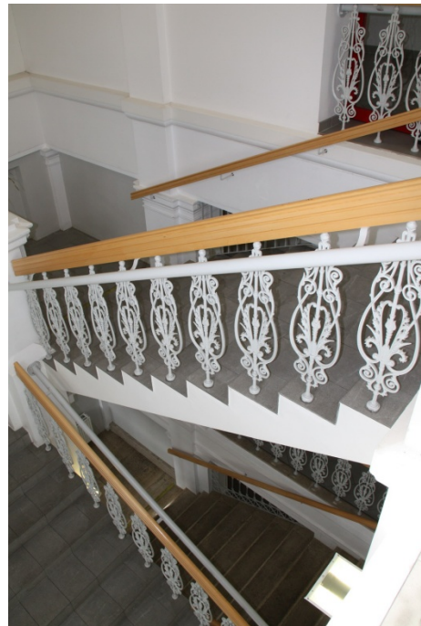
Abb1: BRG6 Hauptstiegenhaus vom DG aus [Aufnahme – Oesterreicher / Sept.2013]
