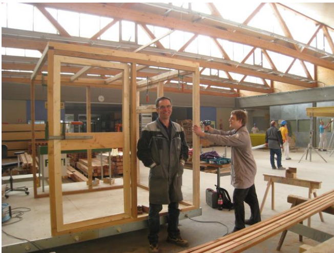
Die HTL Trenkwaldstraße bei der Herstellung des Taubenschlages
