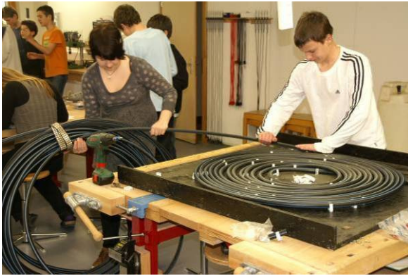
Kollektor – thermische Solaranlage, im Hintergrund: Mostfass (Pufferspeicher)
