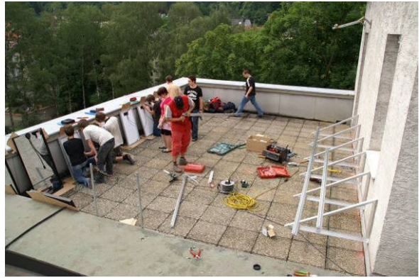
Aufbau der PV-Anlage
