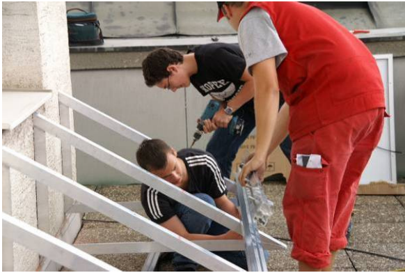
Aufbau der Photovoltaikanlage
