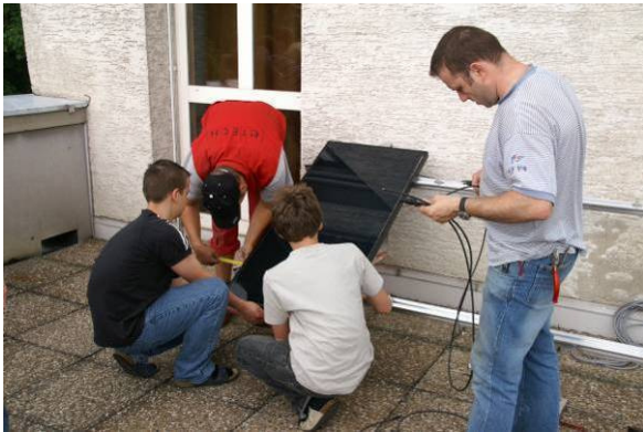
Aufbau der Photovoltaikanlage: Unterstützung durch die Haustechnik
