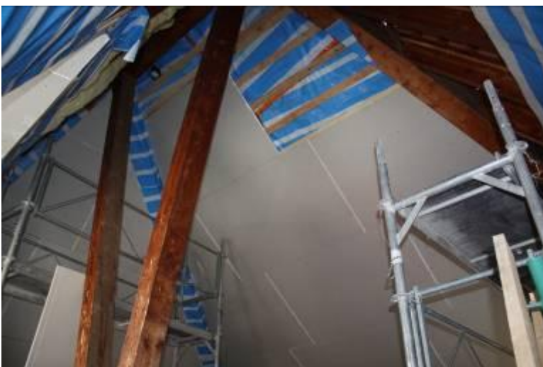
Abbildung 18: Trockenbau mit Konterlattung
