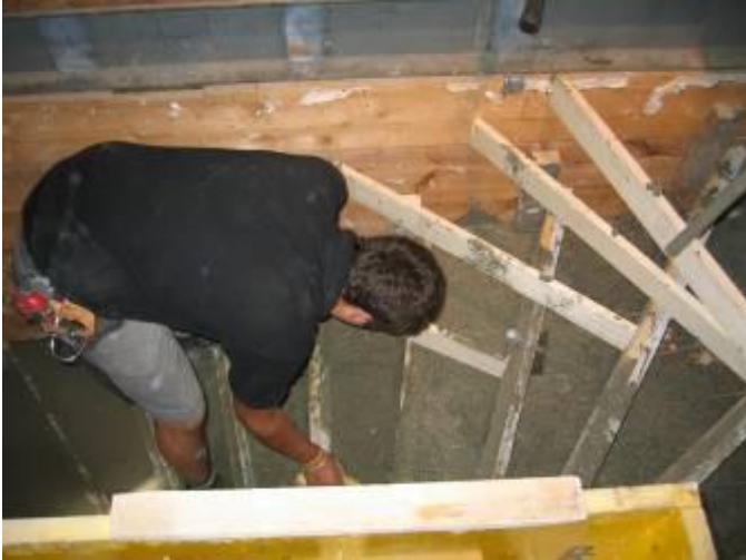
Abbildung 11: Oberflächenbearbeitung der Trittstufen
