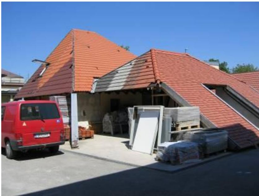
Abbildung 24: Fertig eingedecktes Dach mit Dachflächenfenster
