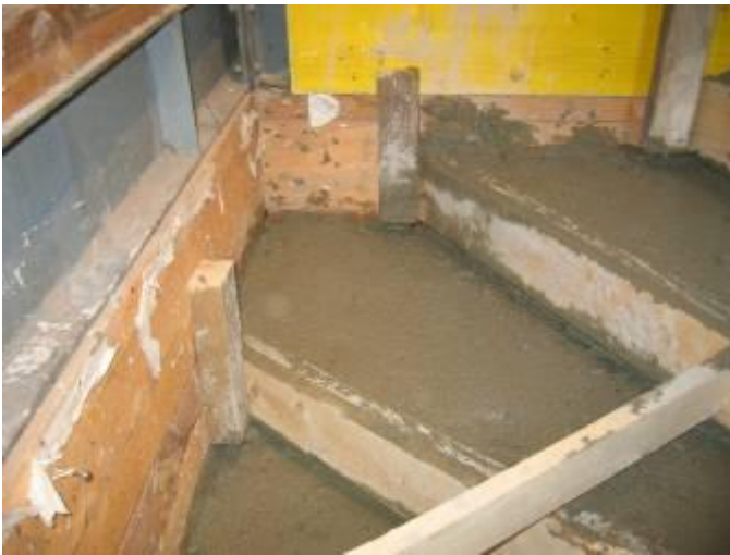
Abbildung 12: Abspreizung der Stiegenschalung
