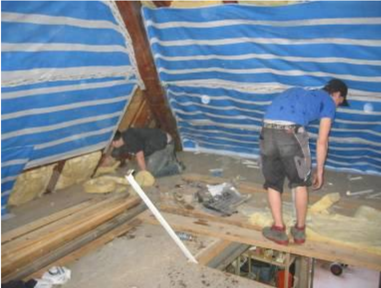
Abbildung 16: Einbringung von Dämmung und Dampfsperre
