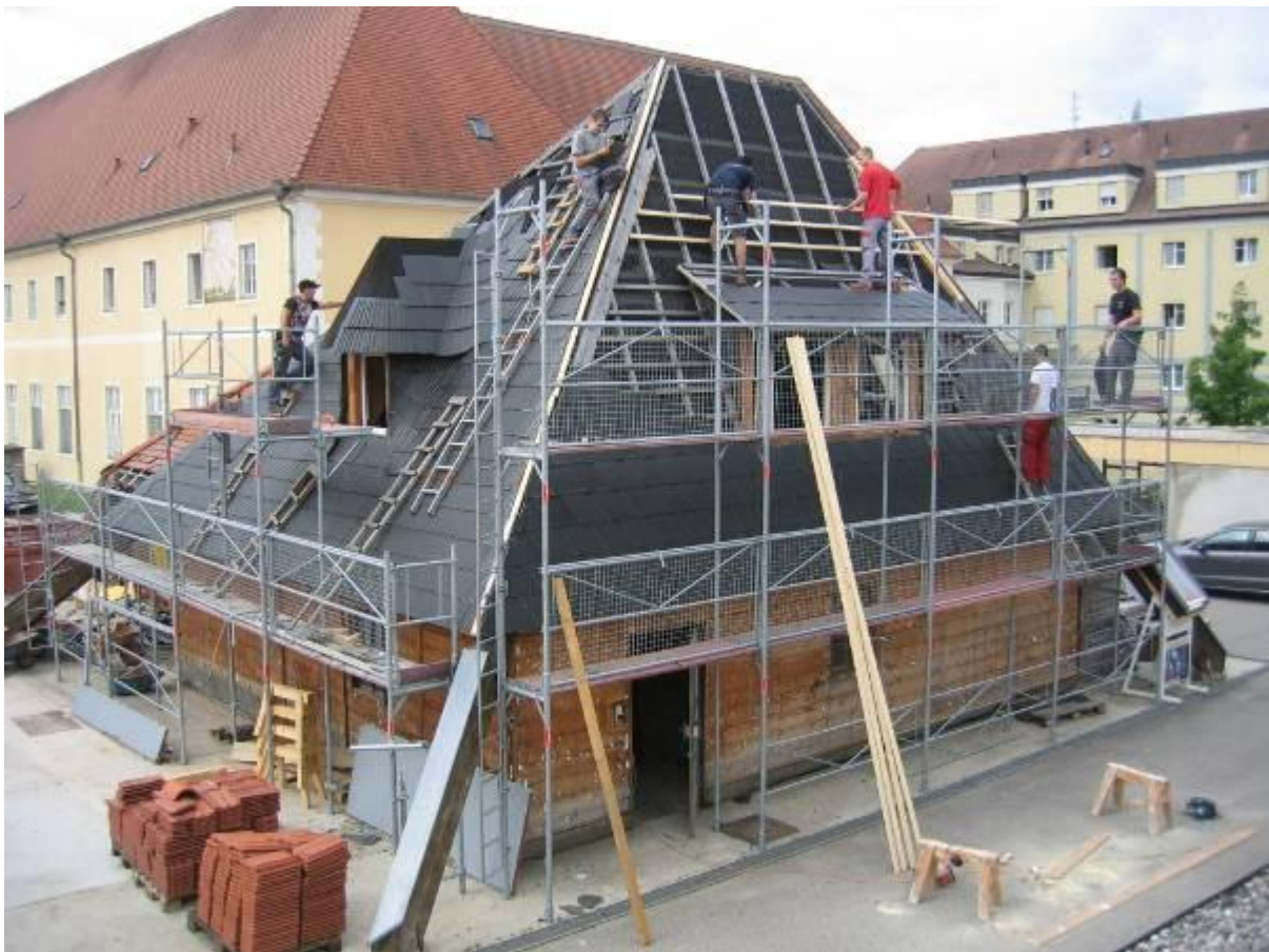
Abbildung 22: Dachdeckung mit Eternitplatten und Außengerüstung
