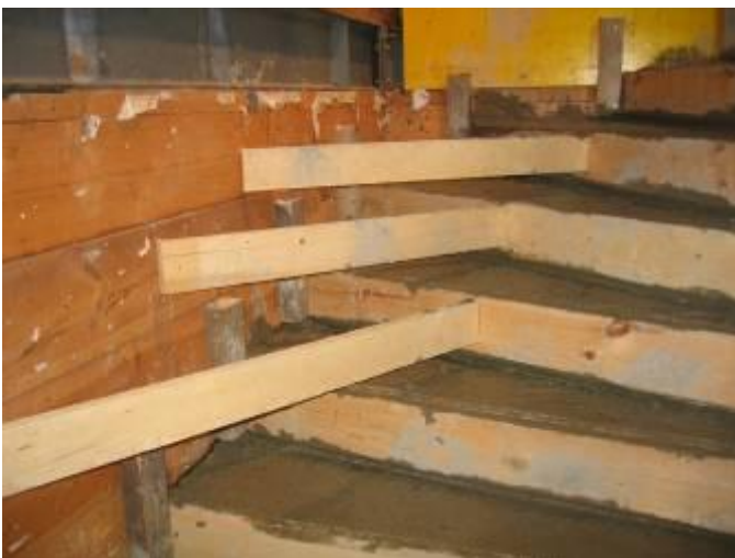
Abbildung 13: Abspreizung der Stiegenschalung
