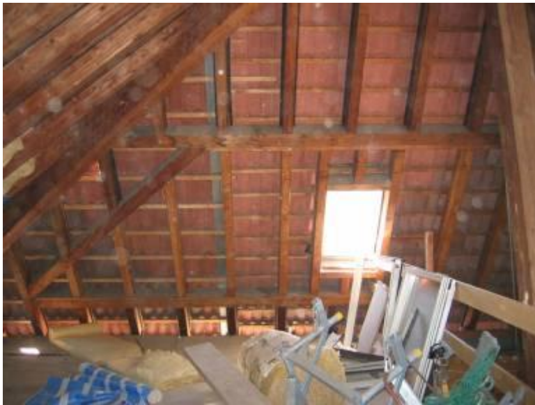
Abbildung 14: Einbau des Dachflächenfensters
