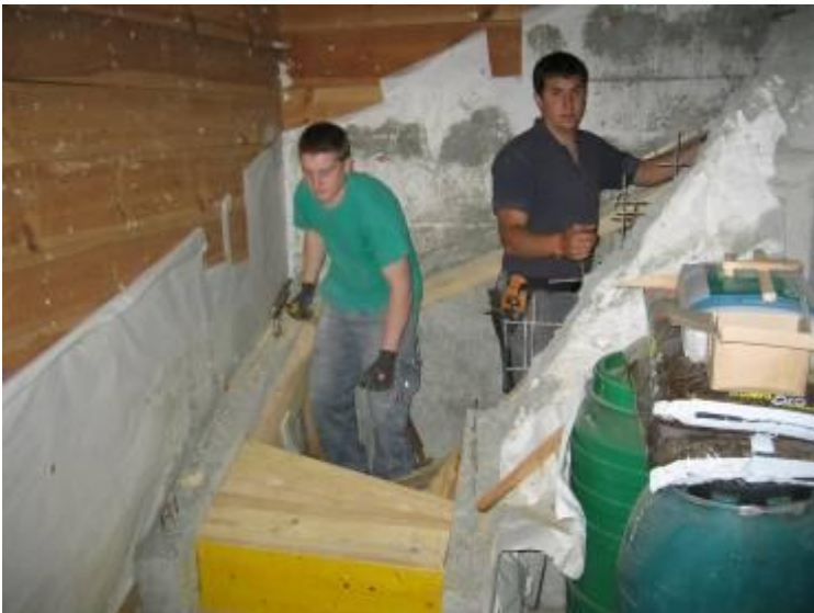
Abbildung 3: Schalung der Laufplatte
