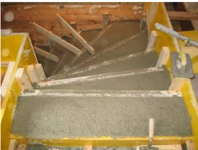
Abbildung 10: Oberflächenbearbeitung der Trittstufen
