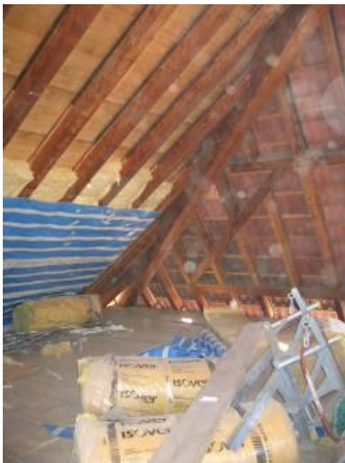
Abbildung 15: Zwischensparrendämmung
