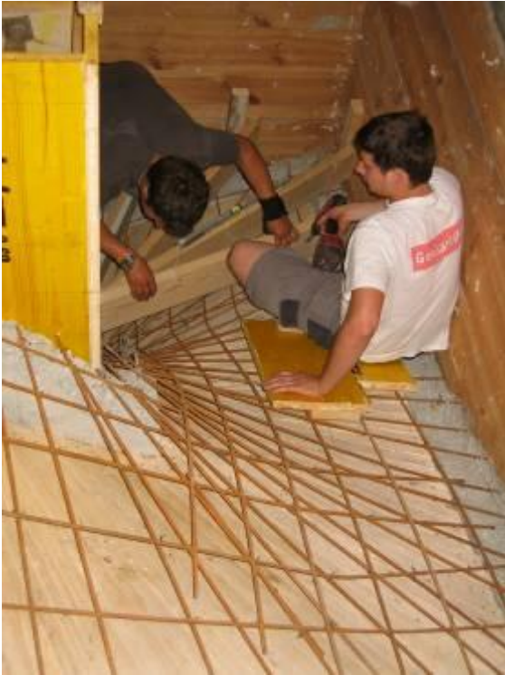
Abbildung 5: Montage der Stirnschalung
