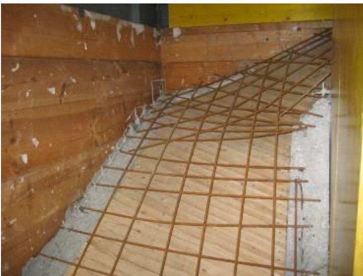
Abbildung 4: Bewehrung der Laufplatte
