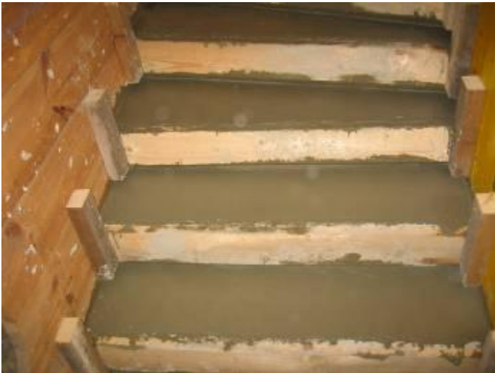
Abbildung 9: Oberflächenbearbeitung der Trittstufen
