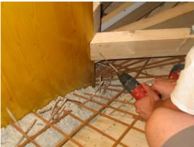
Abbildung 6: Montage der Stirnschalung
