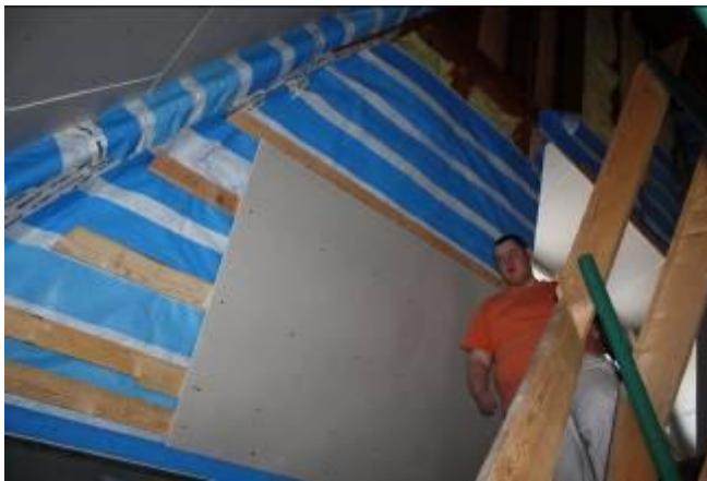
Abbildung 20: Lehrling beim Trockenausbau
