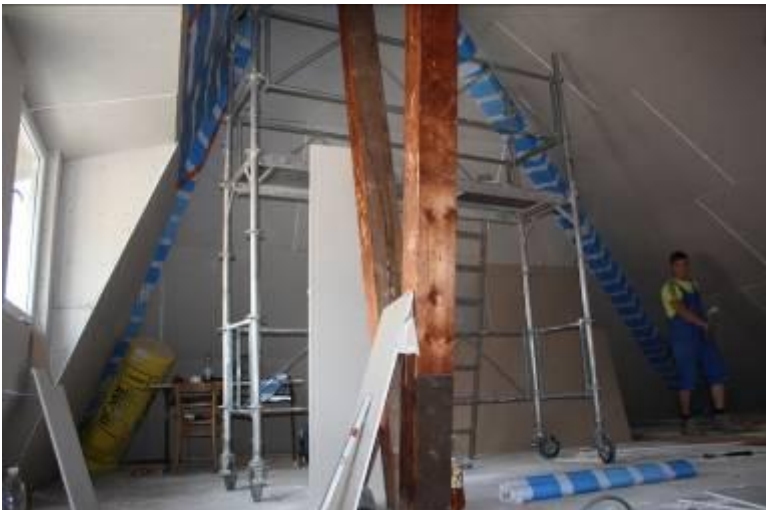
Abbildung 17: Fahrgerüst für den Trockenbau
