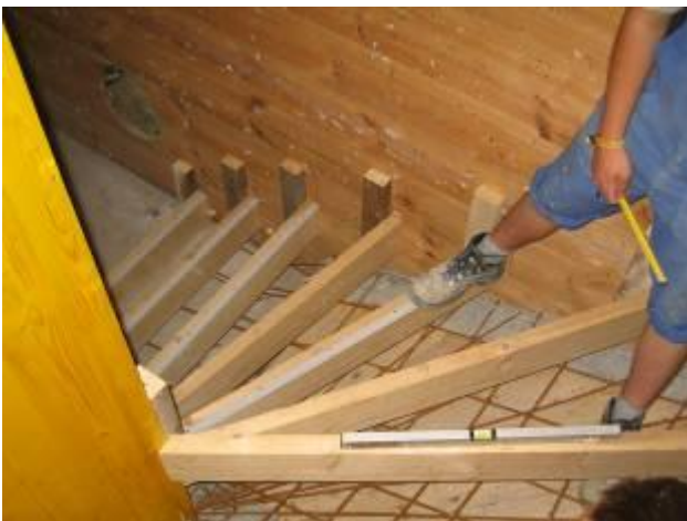
Abbildung 7: Montage der Stirnschalung
