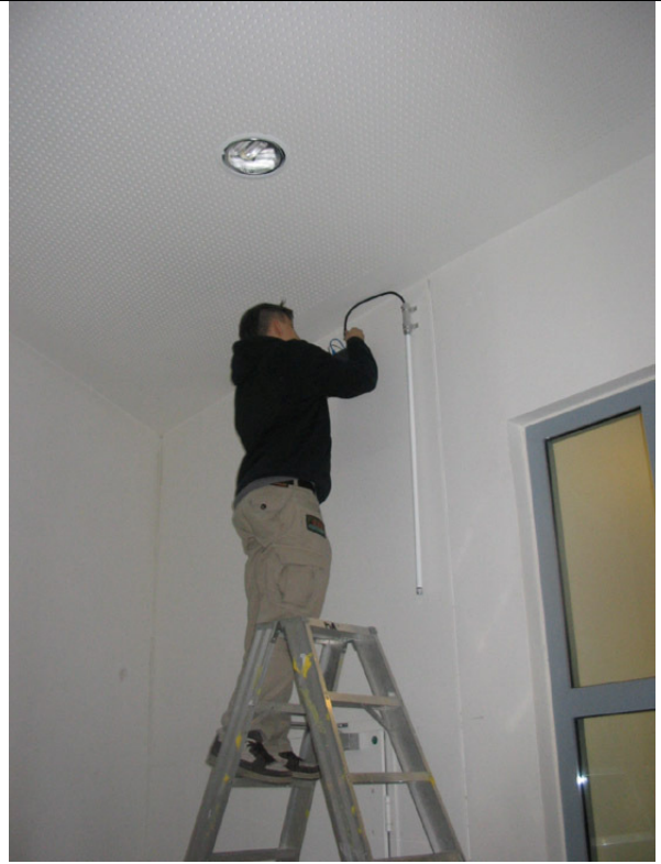
Die Montage eines Access Points
