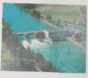
Wasser, das in großen Flüssen fließt, hat Bewegungsenergie, die die Turbinen antreibt. Ein Generator wandelt dann diese Bewegungsenergie in elektrische Energie um. Die Laufkraftwerke dienen zur Grundversorgung mit elektrischer Energie.
