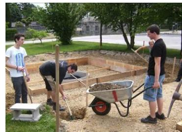
Die tiefste Ebene des Negativeinschnittes, welche von Lehrlingen aus der Landesberufsschule Langenlois mit einem Granitsteinpflaster ausgelegt wurde, füllten die Lehrlinge im Vorfeld mit Kies. Eine Lieferung von 5,4 Tonnen wurde geschaufelt, mit der Schiebetruhe transportiert, und laut den Höhenrissen angeglichen. Für die zweite Ebene der Sitzarena musste eine weitere Fuhrer verteilt werden. Mädchen und Burschen ließen kurzerhand die Tischlerwerkzeuge ruhen und griffen zu Schaufel und Rechen.
